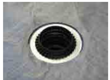
6. Ištraukti montavimo aklę, uždėti drenažinį žiedą HL160
