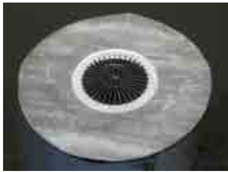
2. Užtepti grunta, priklijuoti 1-ą hidroiziacijos sluoksnį
