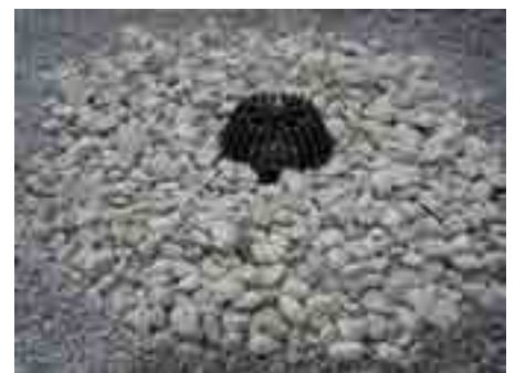
12. Užpilti žvyru likusį stogo paviršių
